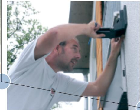
Der erste Wandhalter wird angesetzt und die Löcher für die Bohrung werden angezeichnet.
