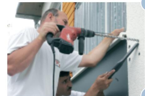
Die Löcher wurden 25 cm tief gebohrt, da sich hier eine 13 cm dicke, nicht tragfähige Isolierschicht auf der Fassade befindet.
