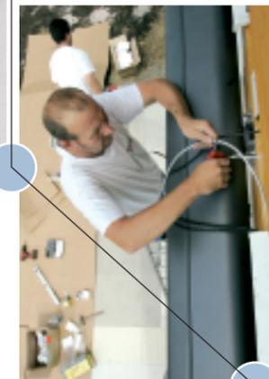
Ein Stromanschluss wird für die Motoren der Markise und der Zusatzfunktion Schattenplus sowie für die Beleuchtung benötigt.
