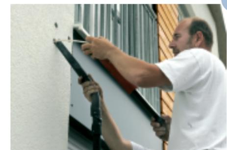
Mit einer Luftpumpe reinigt Siegfried Kasper die Bohrlöcher, da sonst der Kleber nicht hält.
