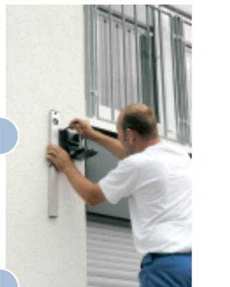
Jeder Wandhalter wird an vier Löchern befestigt, die in die Betondecke gebohrt wurden.
