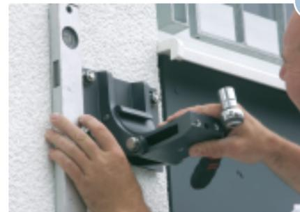
Die Schrauben wurden festgezogen und der Wandhalter mit der Wasserwaage ausgerichtet.
