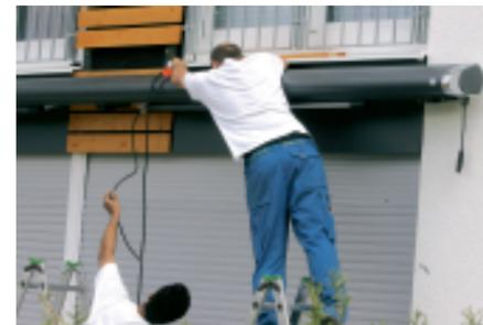
Für den Stromanschluss musste ein Loch durch die Außenwand gebohrt werden.
