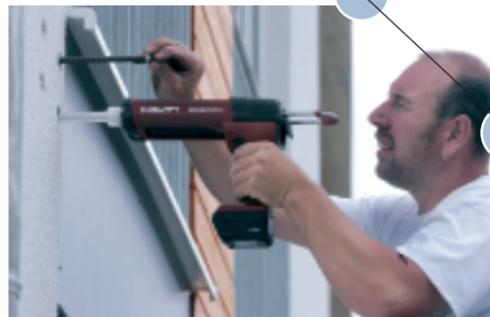
Der Fachmann füllte Zweikomponentenkleber ins Bohrloch und setzt schnell den Gewindebolzen ein.
