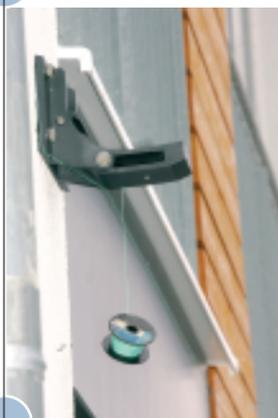
Mit der Schnur wurde für die Montage des dritten Wandhalters in der Mitte eine Flucht gespannt.
